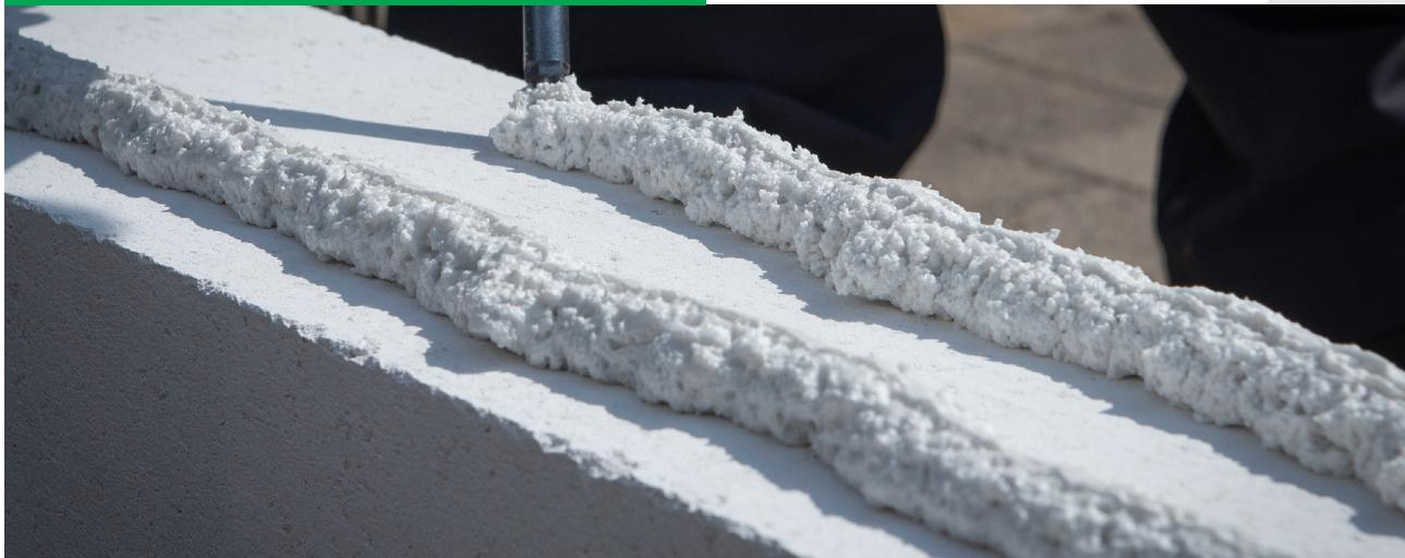
FoamTack Pro Construct ist KOMO-zertifiziert für die Verklebung von tragenden Wänden vorgesehen. Um die besten Ergebnisse zu erzielen, haben wir nachfolgend einige wichtige Richtlinien aufgeführt.
